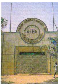
Fachada do Banco Internacional da Guiné-Bissau atingida por vários disparos durante o conflito 1998/1999 . Porta tapada com blocos de cimento IN revista Magazine (DN-Lisboa, Outubro 1999)
